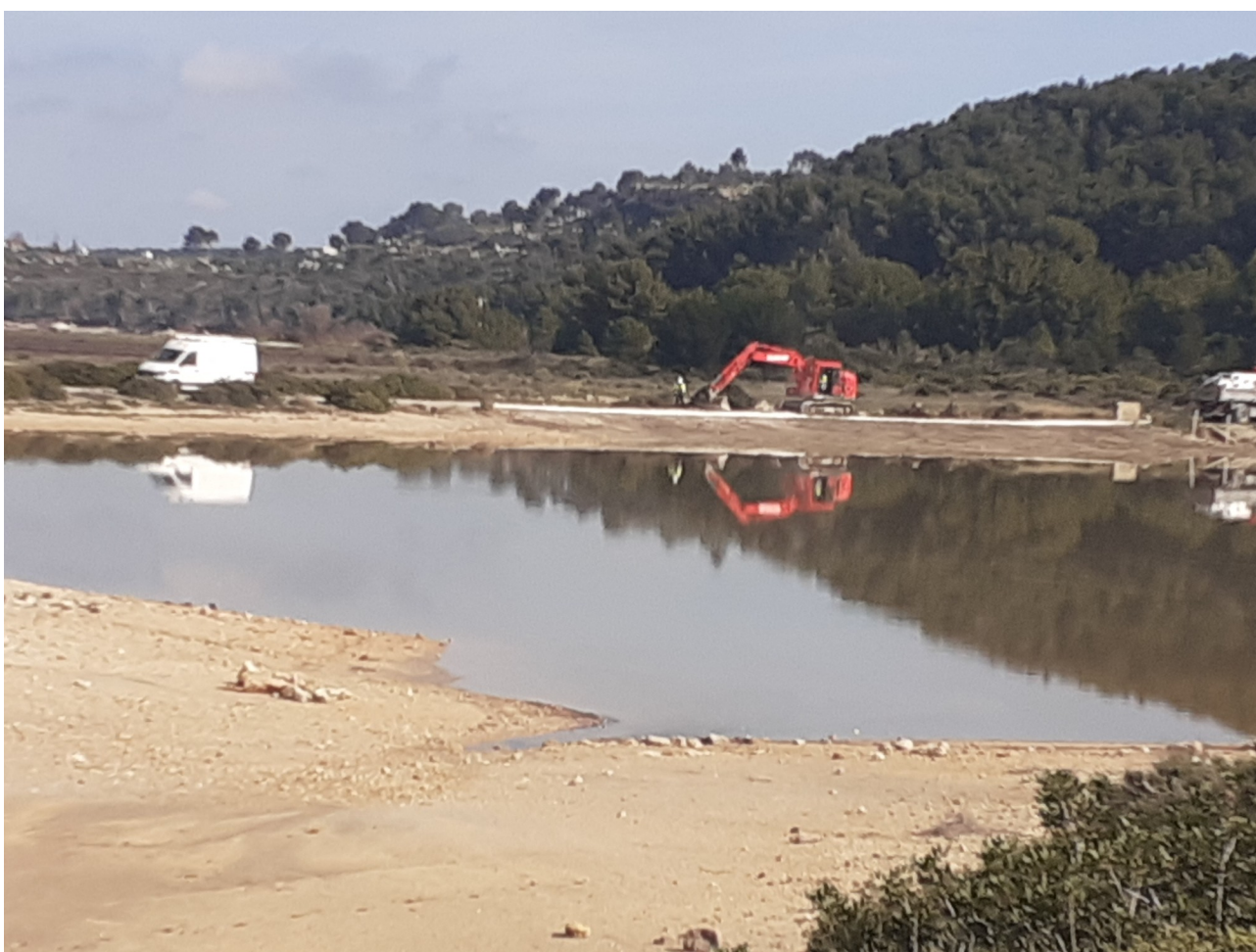
Figure 5: Tractopelle réalisant des travaux de terrassement sur le Plan d'Aren, le 24 mars 2024.
